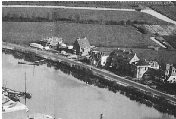
31 Huize Corrie, Haagweg 160 in aanbouw; nr. 166 is gereed. Rechts 32 zichtbaar is Habis Perkara.
