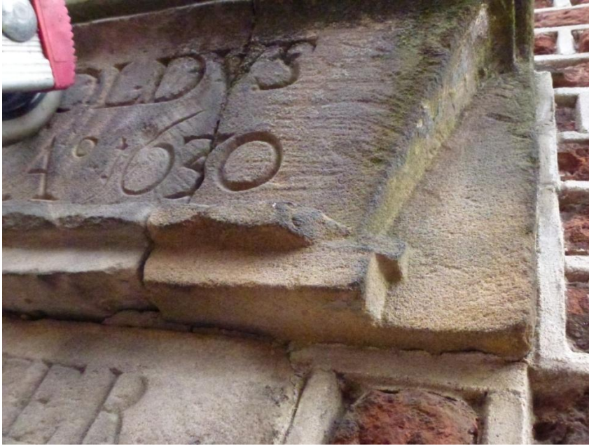
Afb. 8: detail van de sokkel van het beeld, met het rechter stuk zandsteen dat in kleur maar ook textuur zeer verschilt van het linker deel en het stuk eronder.
