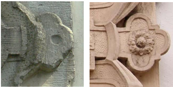
Detail 2 – gelijkvormige randbeëindiging met een soort lipprofiel
