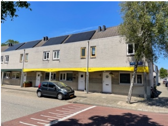
17. Wonen aan de ringweg, o.a. Charley Tooropweg (2021)
