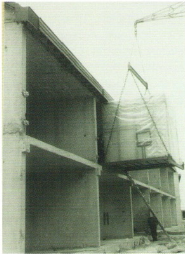
De badkamerunit wordt in het casco van de woning getakeld, Duinen en Dalenbuurt, Merenwijk (bron: Klaassen 2021)
