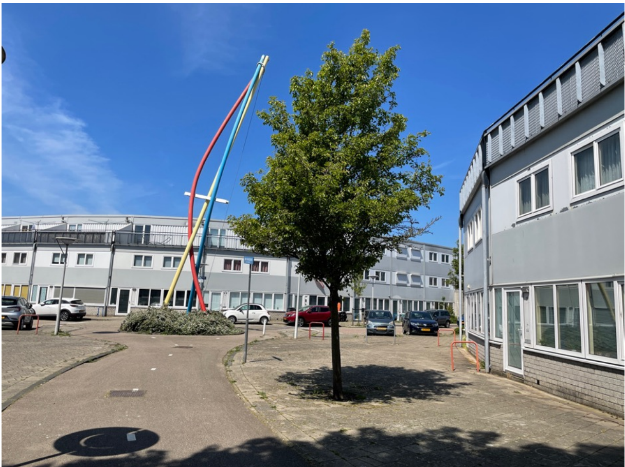
De woonbuurt met experimentele stalen sandwichpanelen aan de gevel, omgeving Margaret Staalstraat (2021)
