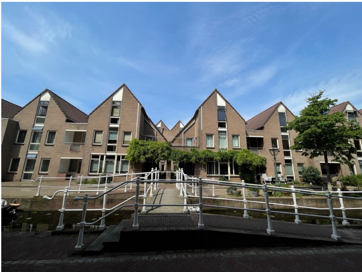
Woningbouw op het terrein Waardgracht-Oranjejgracht (2021)
