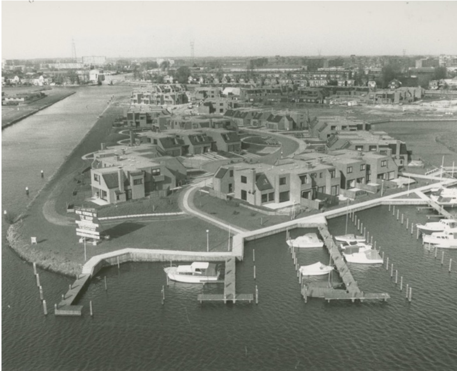
Waardeiland, gezien richting het noorden net na de bouw van het deel van de woningen bij de jachthaven, 1977 (foto: Jan Holvast. Historische vereniging Oud Leiden, Collectie ELO, PV2075.3)
